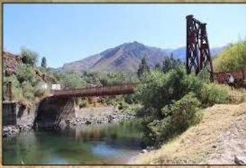
PUENTE DE PILLPINTO
